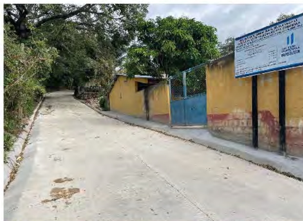
MEJORAMIENTO CAMINO RURAL SECTOR VALLE LA ESCUELA, ALDEA TICANLU SAN JACINTO, CHIQUMULA.
