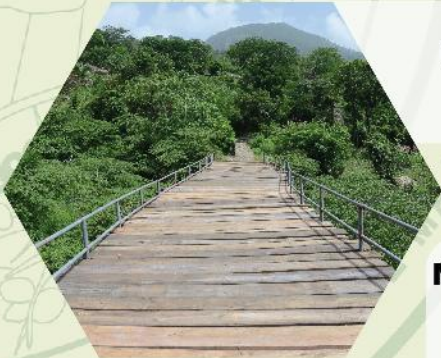
REPARACIÓN PUENTE ALDEA SANTA CRUZ
