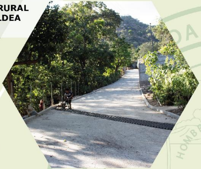
MEJORAMIENTO CAMINO RURAL CASERÍO EL MOJÓN ALDEA CARRIZAL
