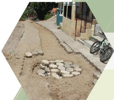
AMPLIACIÓN SISTEMA DE ALCANTARILLADO BARRIO EL TAMARINDO
